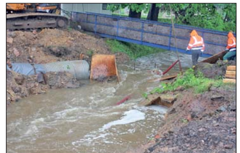
Arbeiter der Firma Schmidt versuchen die Baustelle Fabrikstraße zu sichern
