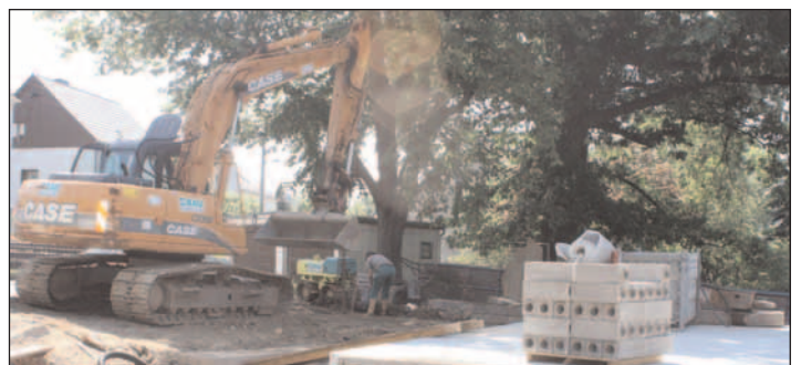
In der Baustelle Fabrikstraße wurden die Betonkörper montiert.
