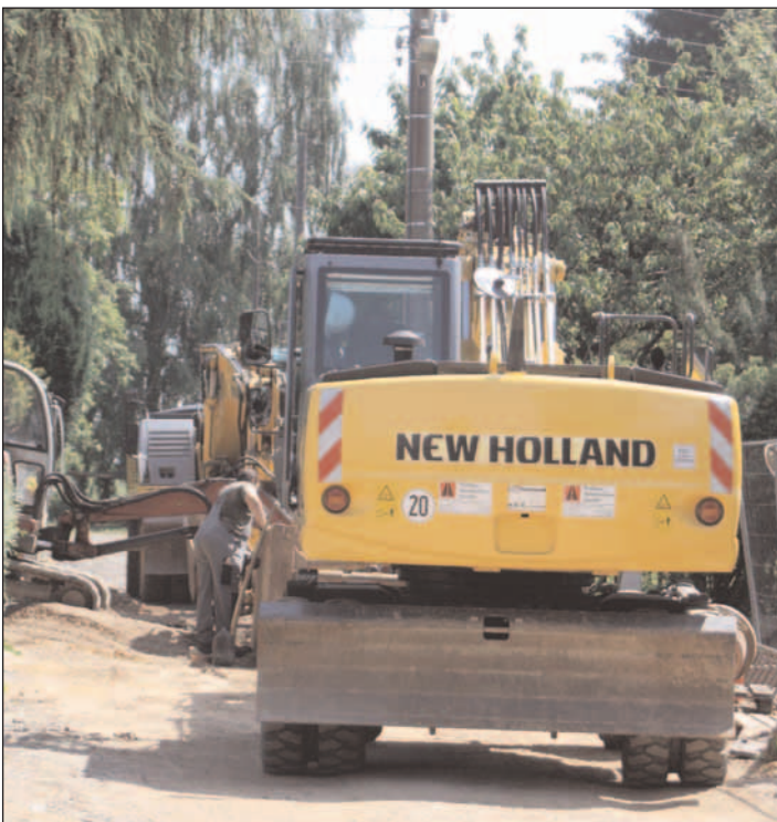
Die Arbeiten an der Abwasseranlage im Pfarrweg gehen voran.
